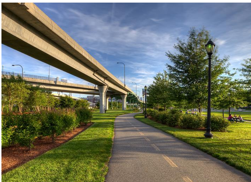
Figura 9 - Parte do troço do East Boston Greenway
