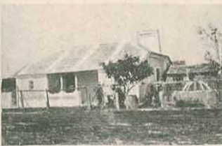
Casa primitiva. Alpendre com uma só entrada e fechando-se com portas de madeira. Alcovas nas salas e mais enfeitada exteriormente.
