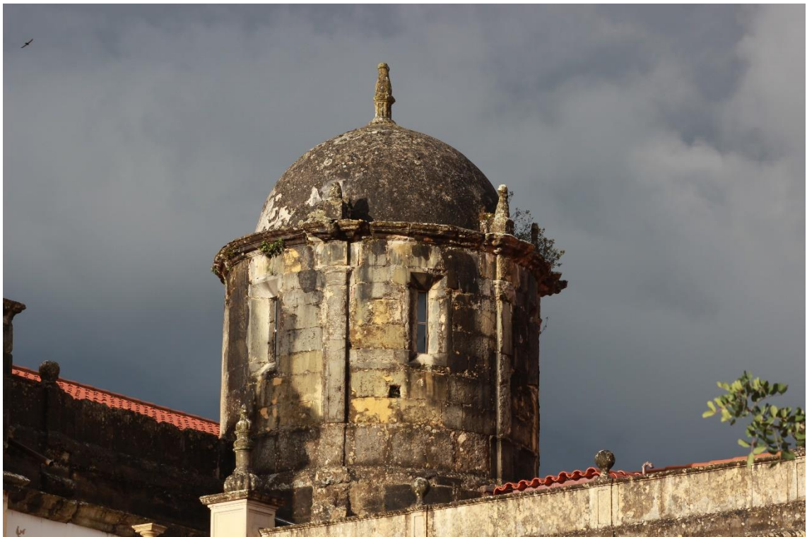
Imagem 52 – Convento de Cristo, Tomar. Torreão, João de Castilho, c. 1545- 1550.
