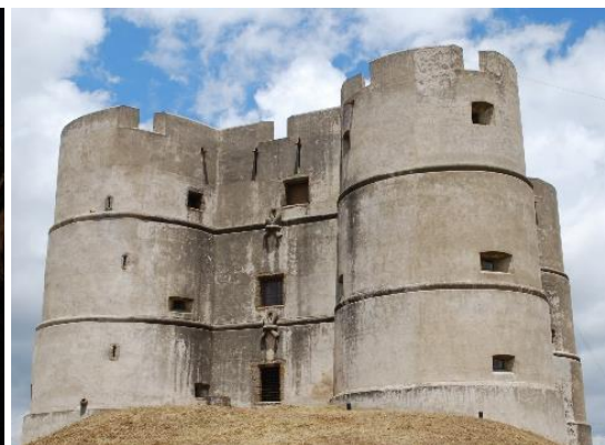
Imagem 69 – Fortaleza roqueira, Évoramonte. Francisco de Arruda, c. 1530
