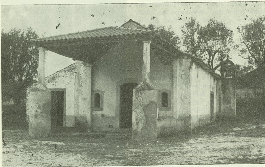
O exterior da Capela com os pilares reempregados e o pequeno campanário
