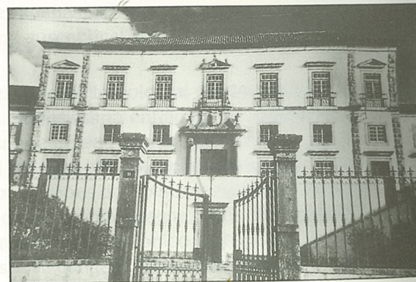
6. Palácio dos Duques de Aveiro (Azetão). Fachada principal, corpo central.
