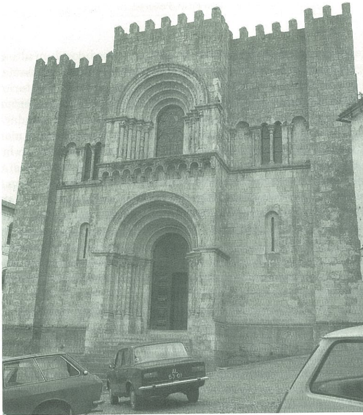
Fig. 2 – Perspectiva do estado actual da fachada da Sé Velha
