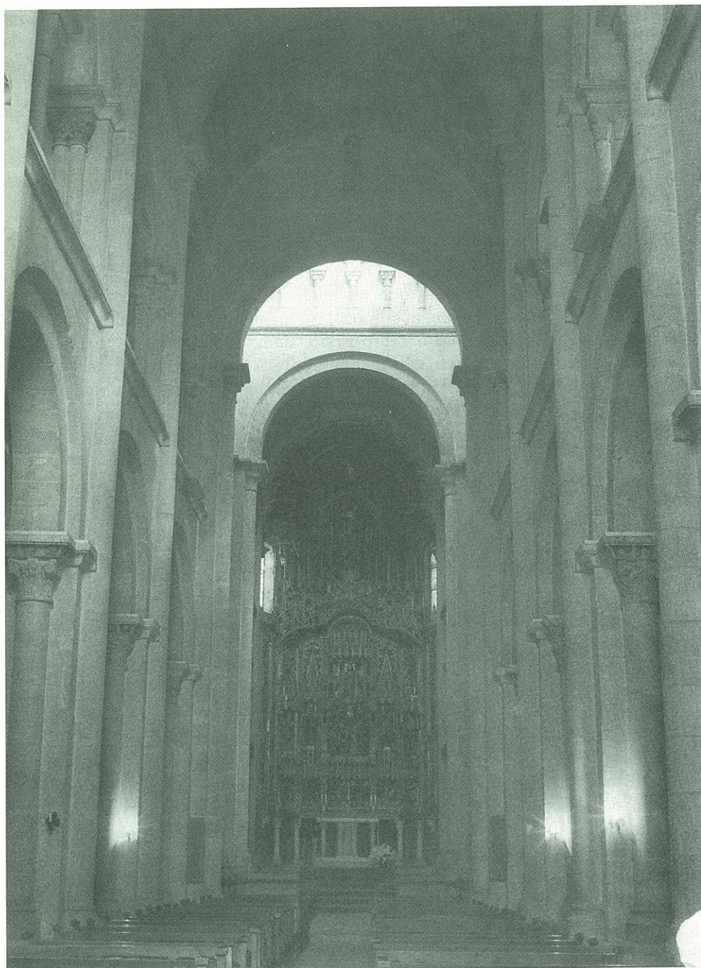
Fig. 4 – Perspectiva interior, com as galerias e a zona do cruzeiro iluminada pela torre-lanterna
