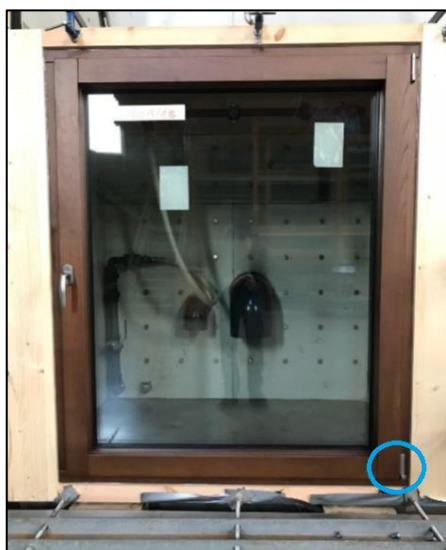
Figura 5.4 - Identificação do ponto onde se verificou a perda de estanquidade à água da janela.
