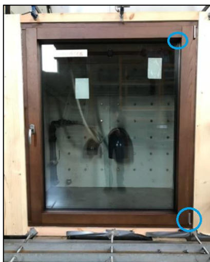
Figura 5.3 - Pontos onde se identificaram as fugas de ar mais significativas.
