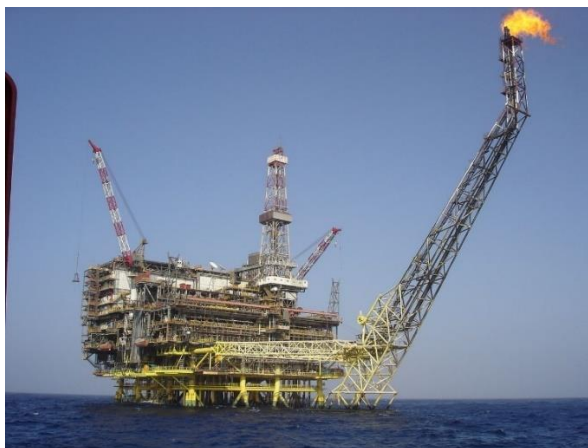
Figura 1-1 – Exemplo de estrutura offshore: plataforma Bouri Field (Wikipédia@, 2016).
