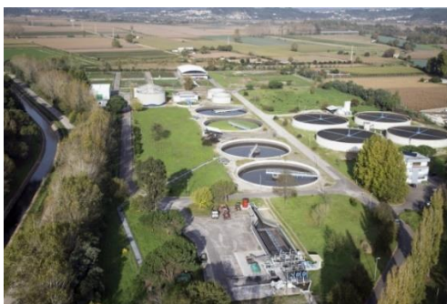
Figura 3.2 – Vista aérea da ETAR do Choupal, Coimbra (retirada www.aguasdocentrolitoral.pt ,2015)
