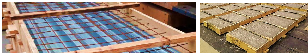
Figura 3.7 – Preparação dos provetes antes e após a betonagem
