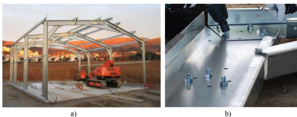
Figura 2.1 – Modelo Delta + ; a) exemplo de uma estrutura Delta + ; b) pormenor ligação viga-pilar (Frisomat, 2018)
