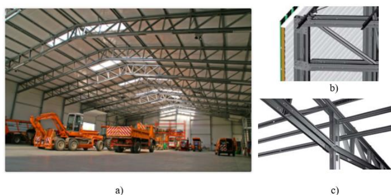
Figura 2.6 – a) Modelo Astra ; b) pormenor ligação das cordas aos pilares; c) pormenor da possibilidade de considerar uma consola após o pilar (Frisomat, 2018)
