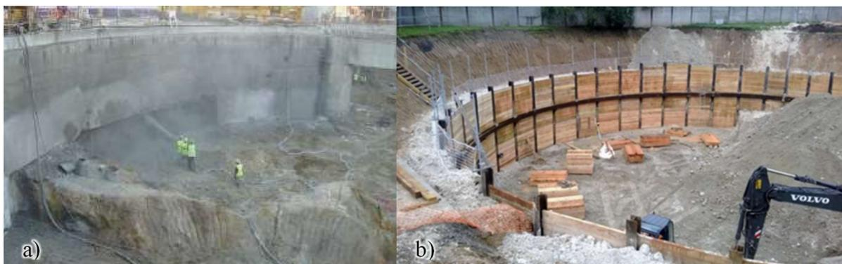
Figura 2.3 – Sistemas de suporte: a) Aplicação de betão projetado em escavação sequencial (Topa Gomes, 2008); b) Muros de Berlim (Arabian Boring General Contracting).
