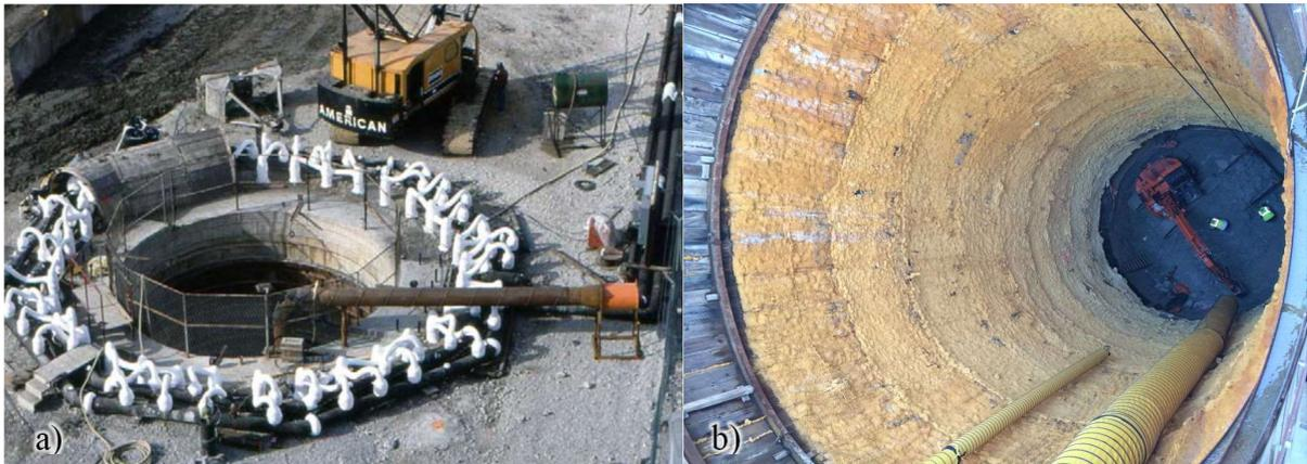
Figura 2.6 – a) Instalação de congelação (Doig, 2012); b) Poço escavado em solo congelado (Popular Mechanics).
