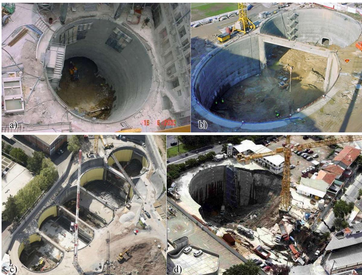
Figura 1.1 – Exemplos de escavação de poços de diferentes geometrias e caso de acidente: a) Estação Bolhão – Metro do Porto (Topa Gomes, 2008); b) Estação Salgueiros – Metro do Porto (CJC Engenharia e Projetos); c) Estação Reboleira – Metro de Lisboa (Sotecnisol SA) d) Acidente na estação Pinheiros – Metro de S. Paulo (Topa Gomes, 2008).
