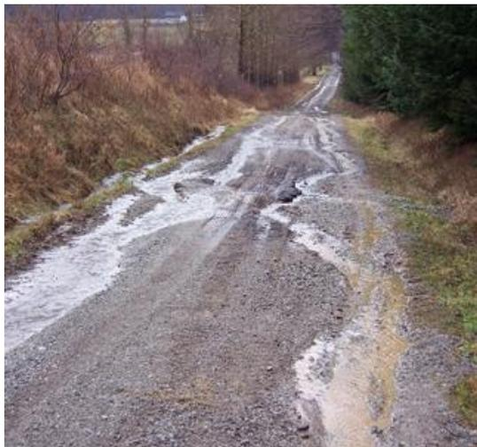
Figura 2.10 – Exemplo representativo de uma secção transversal inadequada (Cruz, 2005)
