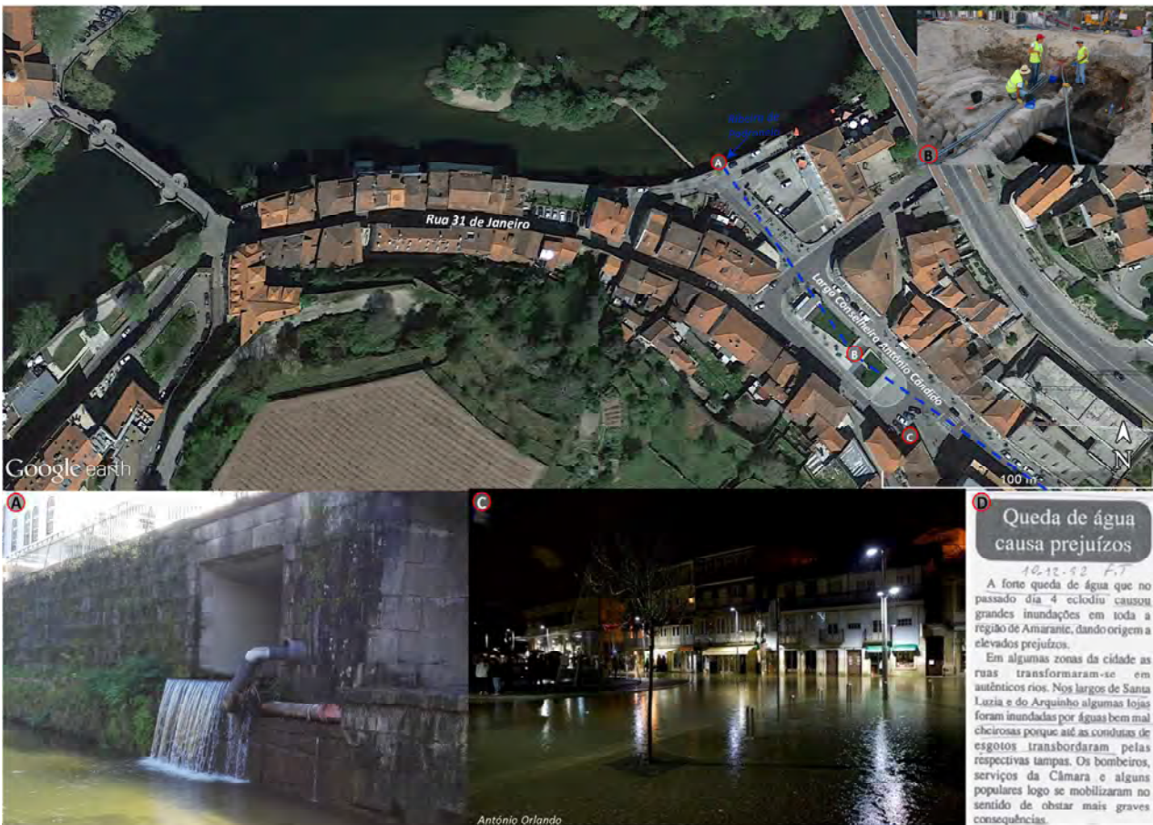
Figura 9 - (A) Local onde a ribeira de Padronelo desagua no rio Tâmega; (B) Trabalhos efetuados na ponte medieval que ligava as duas margens da ribeira de Padronelo, situada no centro do Largo Conselheiro António Cândido (fonte: FERNANDES et al., 2010); (C) Cheias de janeiro de 2016 no Largo Conselheiro António Cândido; (D) Jornal Flor do Tâmega, 10 de dezembro de 1992 (fonte: COSTA, 2009).
