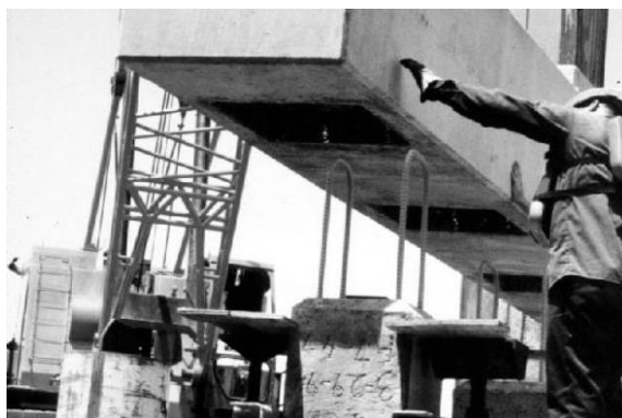
Figura 2.16 – Colocação da viga de diafragma na ponte de Redfish Bay, Texas, Estados Unidos, 1994 (Roddenberry e Servos, 2012)
