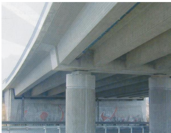
Figura 2.12 – Ponte contínua com vigas pré-fabricadas rectangulares (FIB, 2004)
