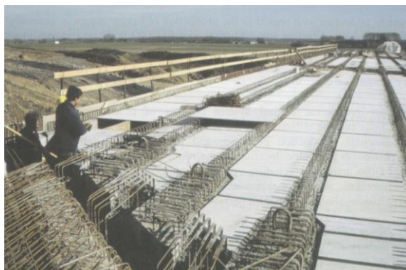
Figura 2.23 – Colocação de tábuas de cofragem para betonagem da laje in situ , Ergon, Bélgica (FIB, 2004)
