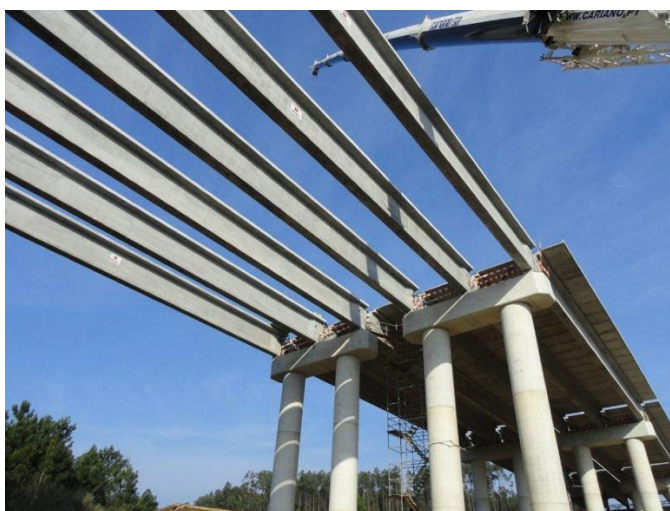
Figura 2.7 – Tabuleiro em vigas I do viaduto da Ribeira da Calvaria, IC2 (Indubel,2010)
