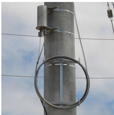
Figura 21 – Caixa de Fusão de fibra ótica de exterior.
