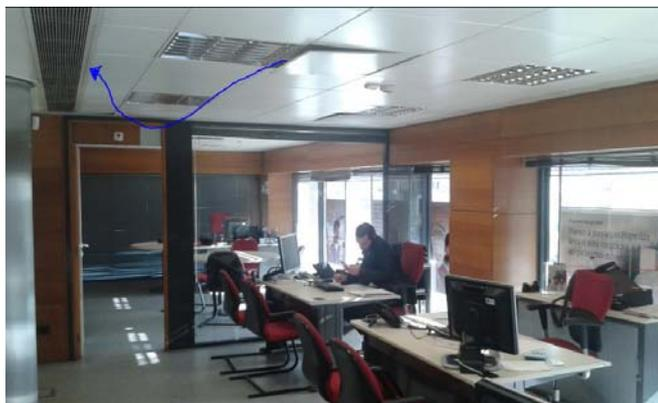
**Figura 4.6 Difusor de insuflador na agência de Odivelas (imagem adaptada)**
