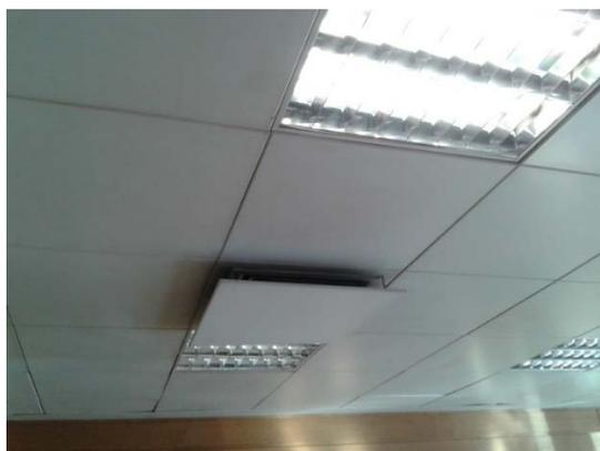
Figura 4.5 Difusor de insuflação existente na agência de Grijó
