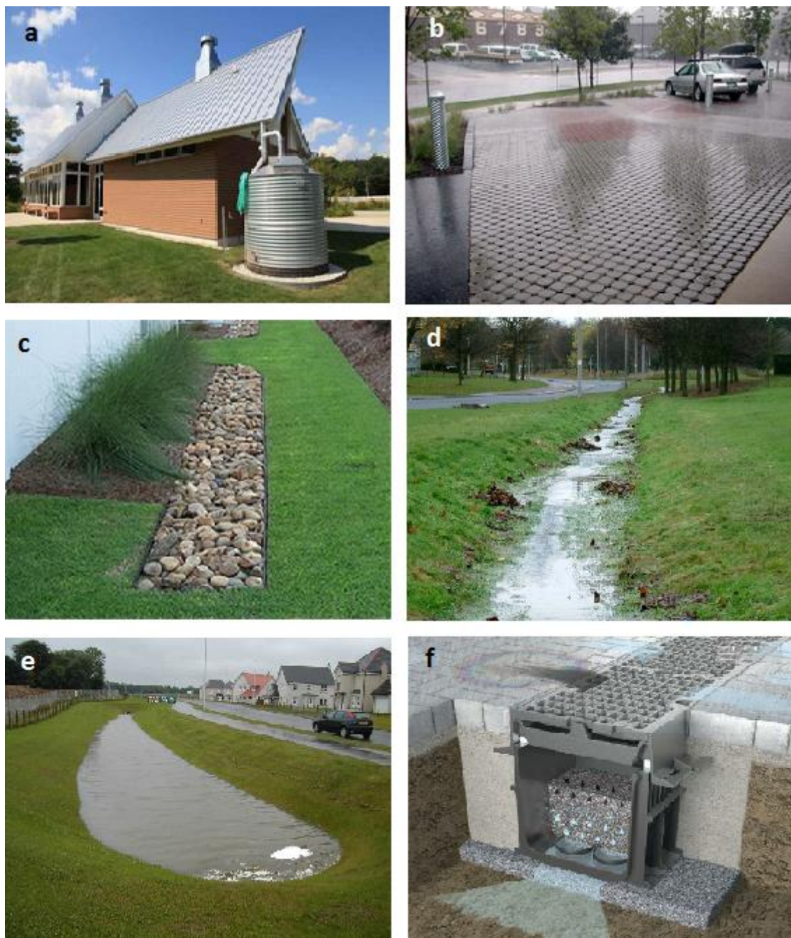
Figura 2.7 - Tipos de SUDS – (a) Depósito de armazenamento de águas pluviais (ERAhbt@, 2017); (b) Pavimento permeável (SUDSnet@, 2017b); (c) Trincheira de infiltração (SUDSWales@, 2017); (d) Vala com cobertura vegetal (SUDSnet@, 2017c); (e) Bacia de retenção (SUDSnet@, 2017a); (f) Sistema de tratamento (Storm-Water@, 2017)
