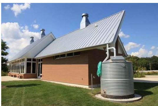
Figura 3.13 - Depósito de armazenamento de águas pluviais ((ERAhbt@, 2017)
