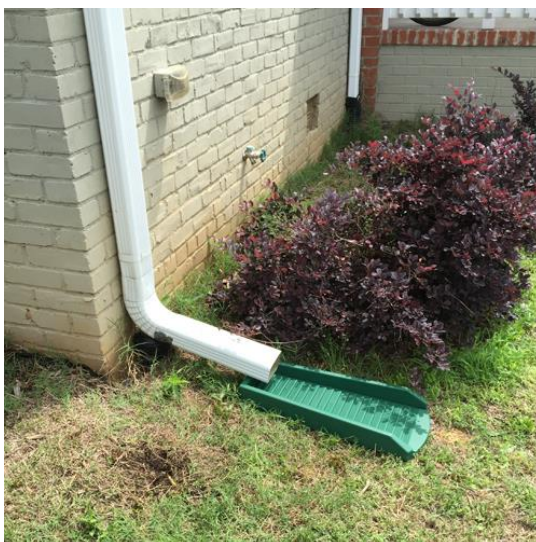
Figura 3.12 - Desconexão de telhado (Creeksmart@, 2017)
