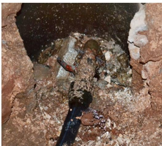
Figura 2.1. Fuga no acessório de seccionamento do ramal de ligação - Fonte: autor
