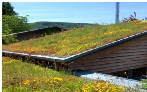
Figura 2.12 – Cobertura verde extensiva (retirado LANDLAB®, 2016)
