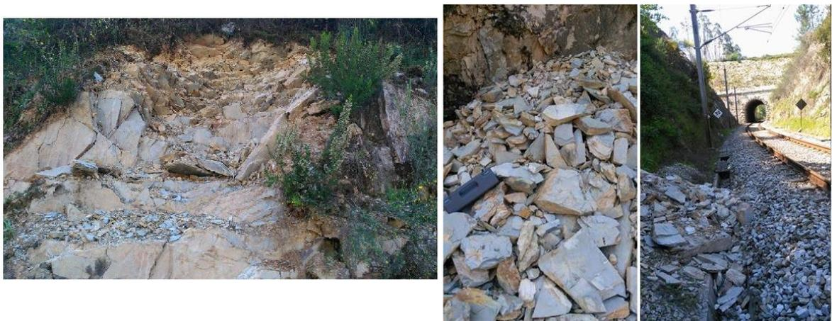
Figura 3.4: Queda de blocos no talude do lado direito.
