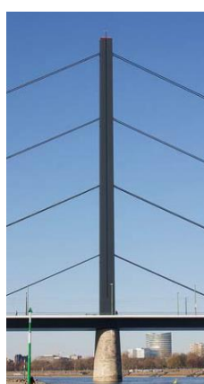
a) Torre de fuste único vertical (Calado, 2011)
