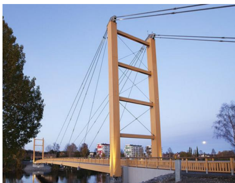
a) Ponte de Älvsbacka na Suécia [Imagem 11]
