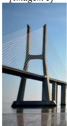
g) Torre em pórtico transversal [Imagem 7]
