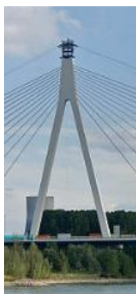
h) Torre em pórtico longitudinal [Imagem 8]
