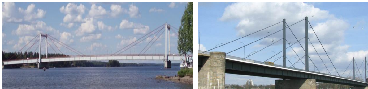
a) Ponte de Strömsund na Suécia [Imagem 2] b) Ponte Theodor Heuss em Düsseldorf na Alemanha [Imagem 3]
