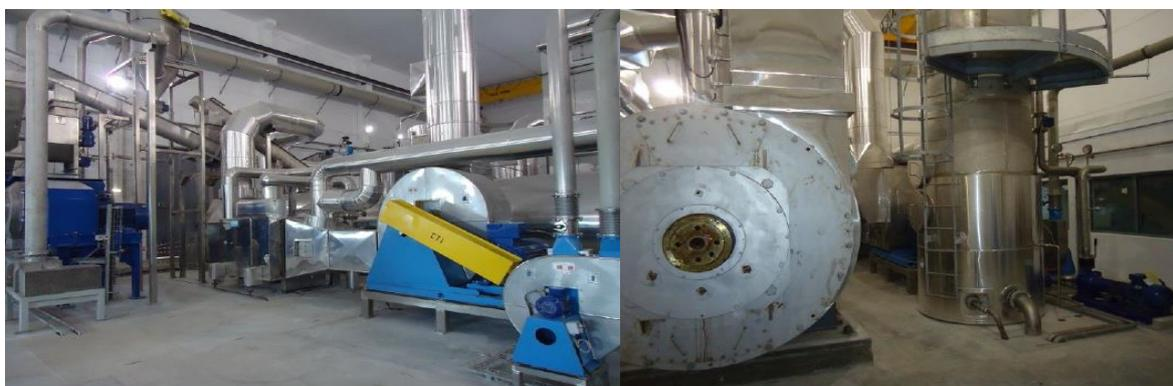
Figura 4.12 - Instalação integral do turbo-secador VOMM (Fonte: Cortesia ETAR da Guia, citado em Berco, 2013).
