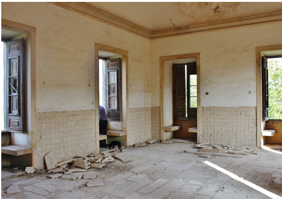
Figura 2.16 – Salão nobre (Primeiro piso do torreão a nascente)
