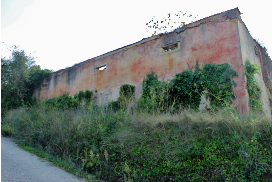
Figura 3.10 – Antiga vacaria, na imediação do acesso rodoviário à propriedade e situada fora da área murada.
