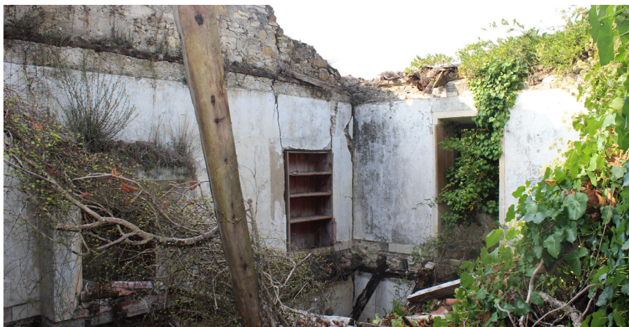
Figura 3.2 – Antiga sala na imediação do coro-alto, atualmente em ruína
