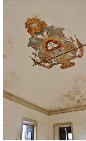
Figura 2.15 – Tecto do salão nobre (Primeiro piso do torreão a nascente)
