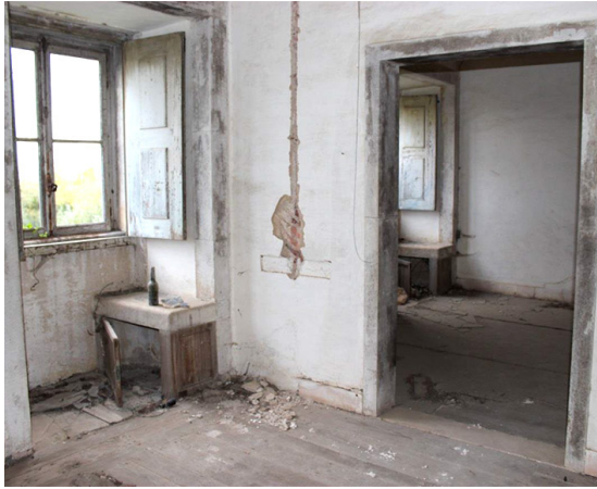
Figura 2.14 – Antiga cela residencial (Ala nascente do primeiro piso do volume dianteiro)
