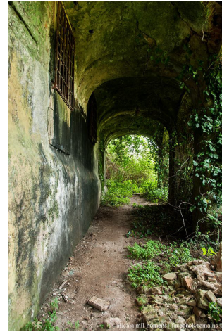
Figura 3.5 – Espaço sob estrutura de arcos ao centro do alçado principal
