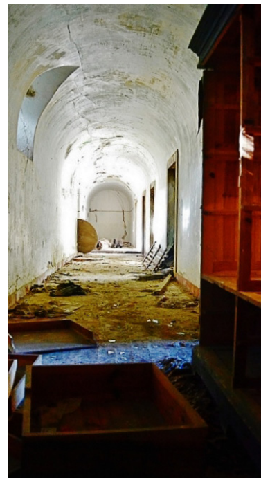
Figura 2.10 – Corredor de serviços (Piso térreo, ala poente)
