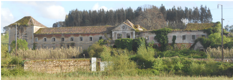
Figura 2.8 – Casa da Quinta de Almiara. 2013
