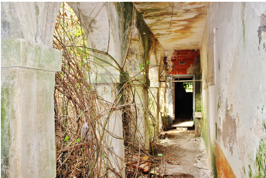
Figura 2.19 – Galeria térrea no corpo transversal a nascente (Ligação transversal ao longo do pátio interno, entre os dois volumes longitudinais, que dá acesso à capela no volume posterior)
