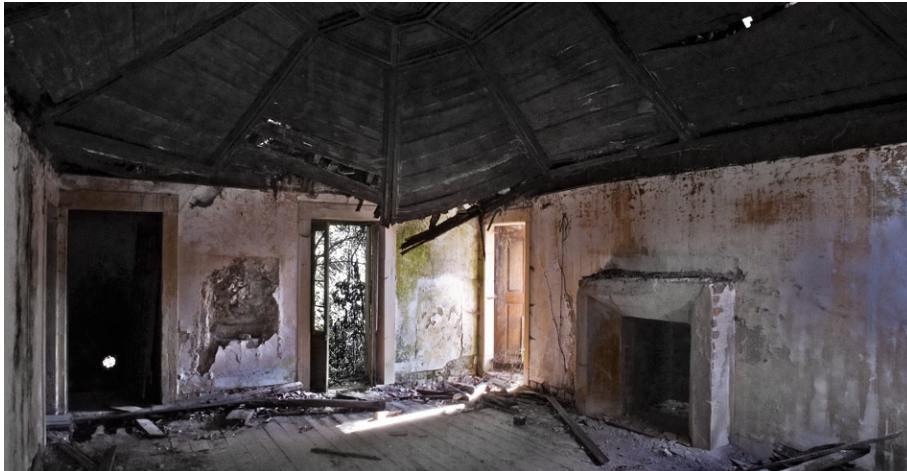
Figura 3.1 – Antiga sala na imediação do coro-alto. 2011 (Primeiro piso do volume posterior)
