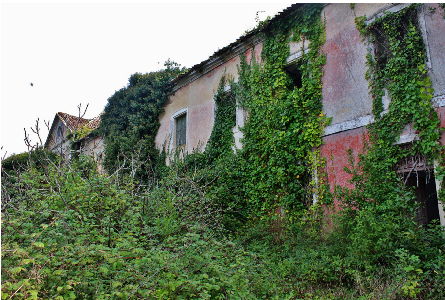
Figura 3.6 – Alçado principal, atualmente
