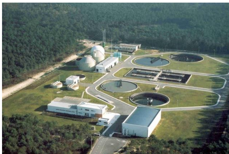
Figura 6 - ETAR do Choupal. Retirado de águasdocontrolitoral.
