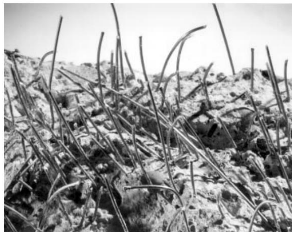
Figura 2.4 - Superfície de rotura de betão reforçado com fibras de aço (ACI Comite 544, 2002).
