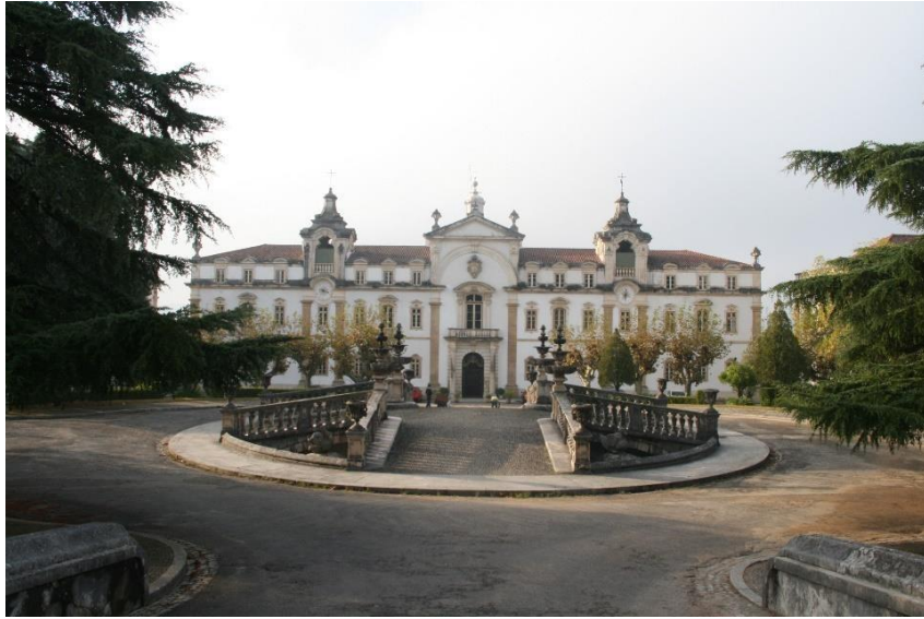
Figura 1 – Vista Geral para a Casa Velha do Seminário Maior de Coimbra.
