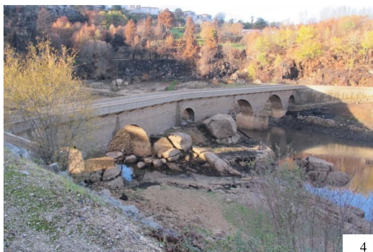
Figura XVIII: 1) Ponte da Barroca de S. Miguel; 2) Calçada antiga do Vimieiro (foto cedida por António Matos); 3) Troço da calçada antiga do Vimieiro; 4) Ponte velha de Santa Comba Dão
