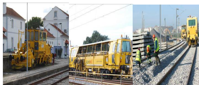
Figura 5 - Equipamento trabalhos de via
