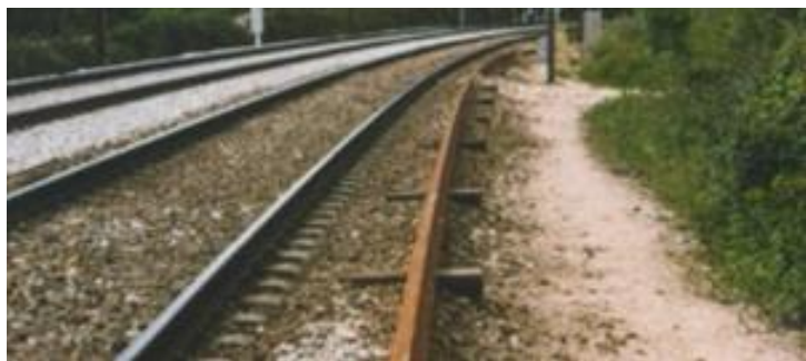
Figura 9 - Carril com tacos 10 em 10 metros
