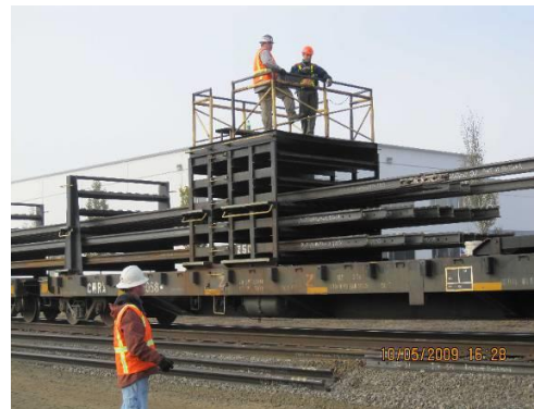
Figura 8 - Comboio de pórticos e carril colocado na banquetta
