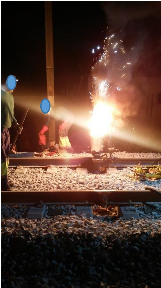
Figura 20 - Soldaduras Aluminotérmicas
