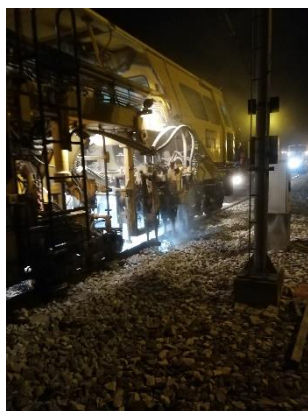
Figura 16 - Braços hidráulicos vibratórios de uma atacadeira
