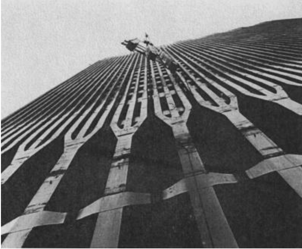
Figura 13- Construção do World Trade Center
