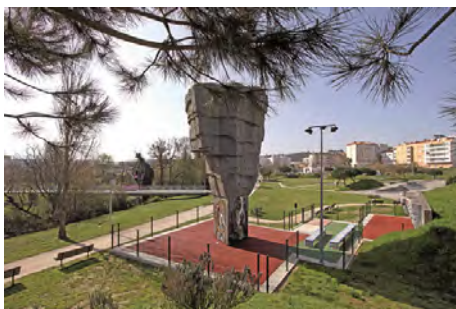
43 | Torre e parede de escalada do Parque Radical de Leiria
