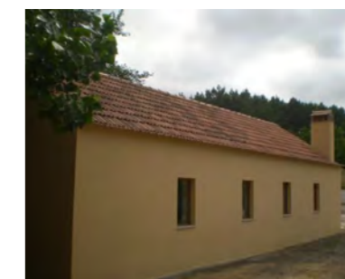
125 | Alçado principal restaurado
