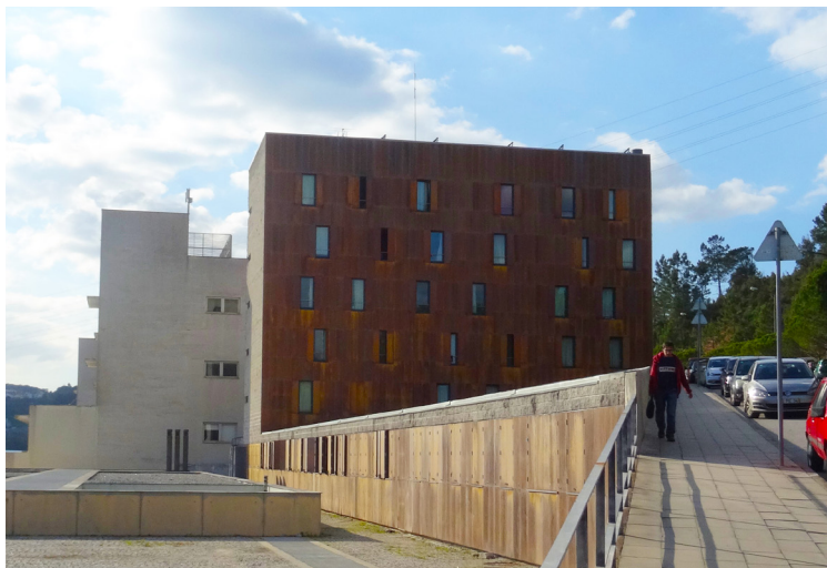
(Figura 26) - Vista a nascente sobre o edifício, 2017.
