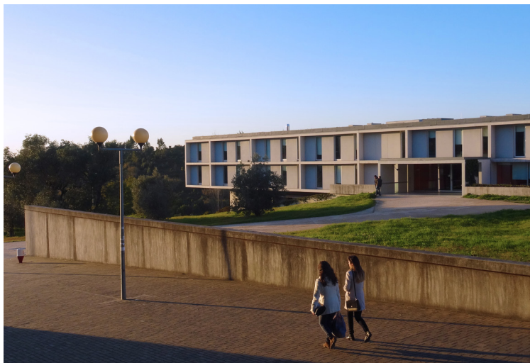
(Figura 39) - Vista a nascente sobre a entrada do edifício, 2017.
