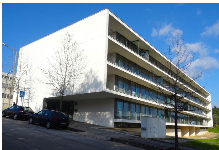
(Figura 33) - Vista a ponte sobre o edifício, 2017.
