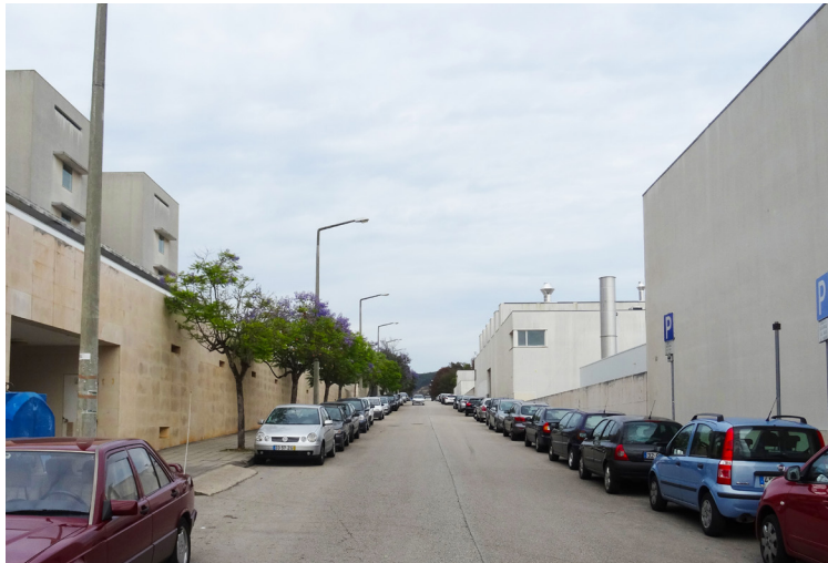
(Figura 50) - Vista a ponte sobre a rua Sílvio Lima, entre Departamento de Engenharia Electrotécnica e o Departamento de Engenharia Civil, Pólo II, 2017.
