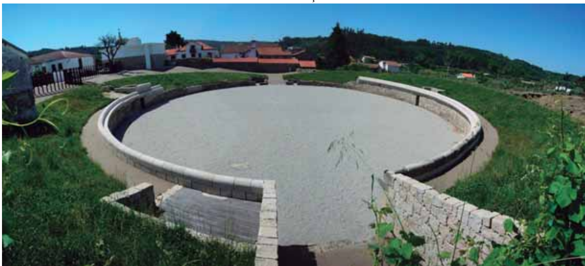
45. ANFITEATRO DA BOBADELA. Após a intervenção de 2008.
