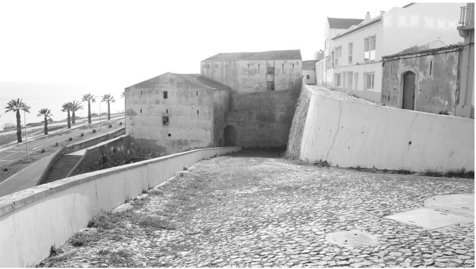
Figura 796 - Armazéns da Calheta, vista da cota superior, estado atual
