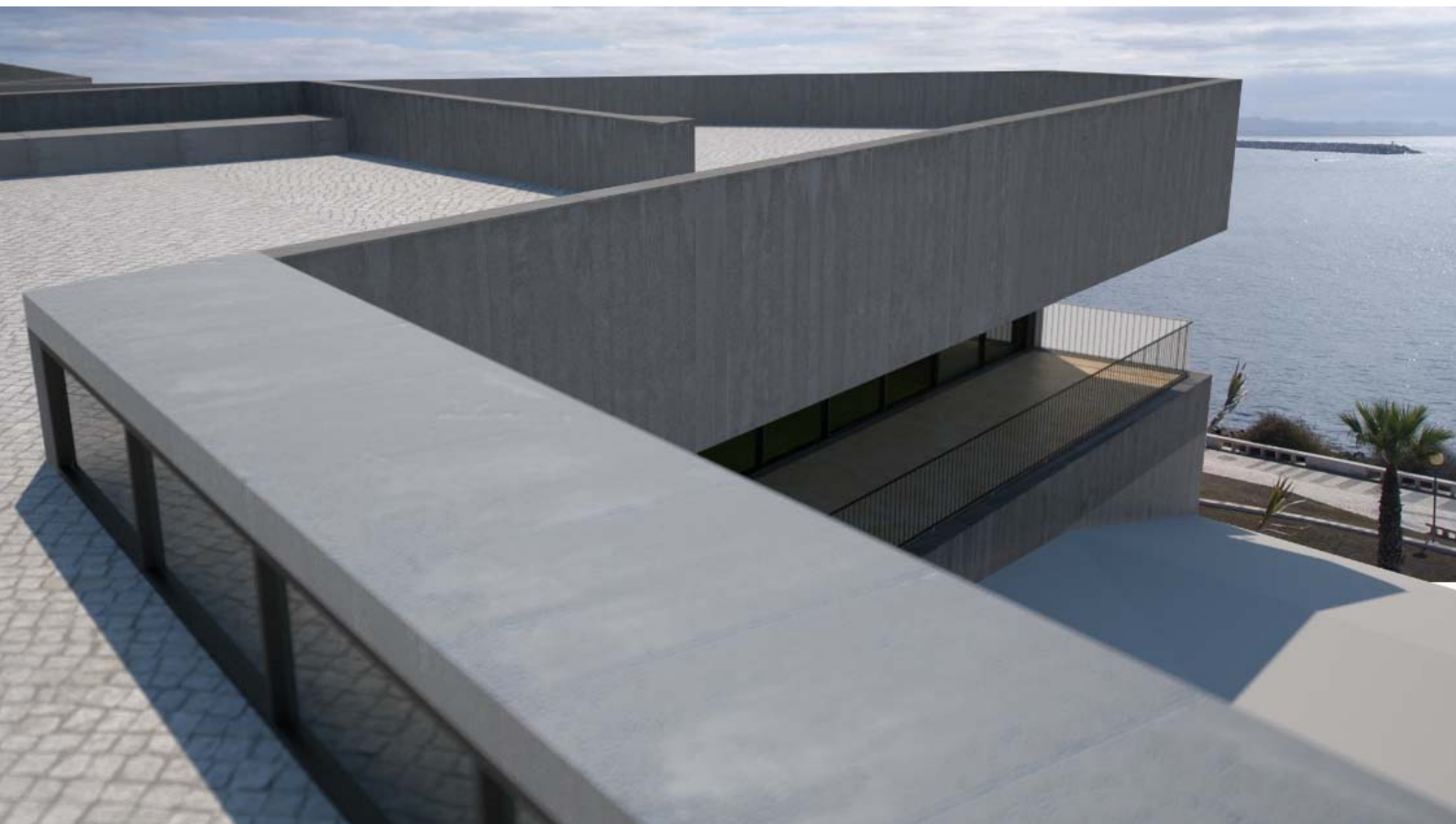
Figura 90 – Percurso na cobertura do edifício, vista panorâmica
