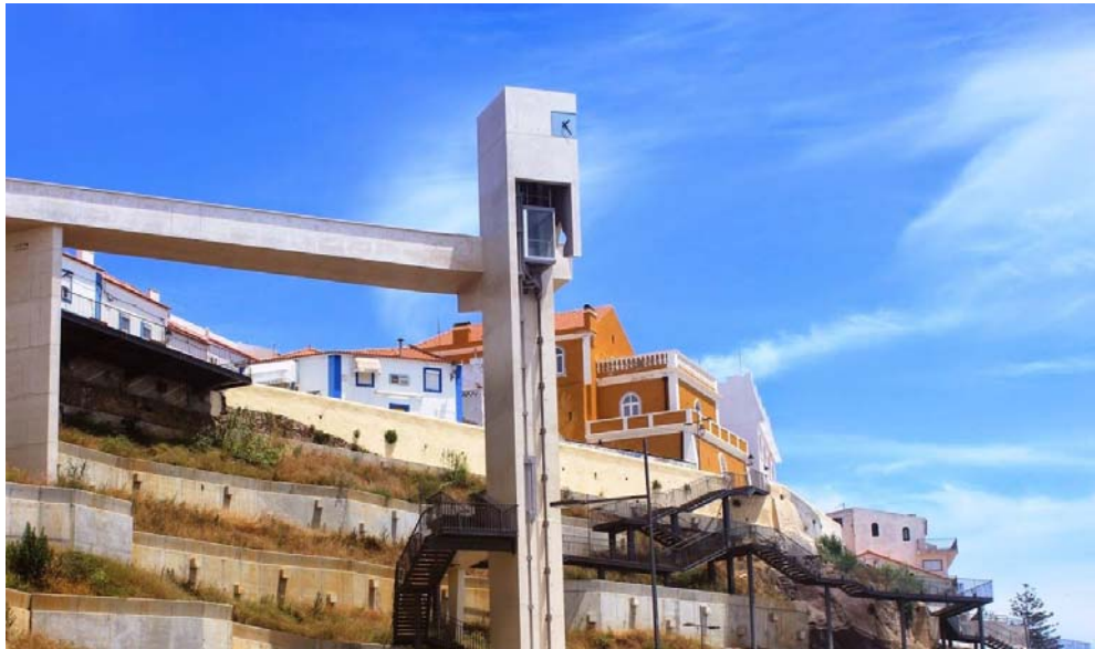
Figura 31 – Elevador Vasco da Gama
