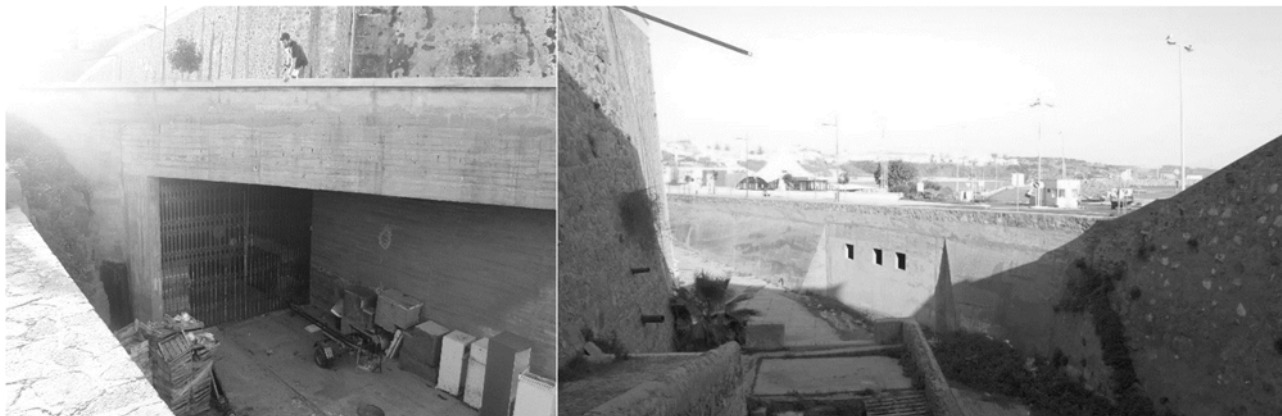
Figura 56 - Túnel que permite a passagem dos armazéns da Calheta para o atual porto de pesca, por baixo da avenida marginal
