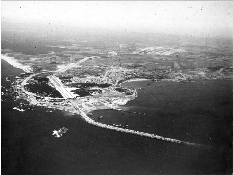
Figura 23 – Construção do terminal de granéis líquidos, 1975
