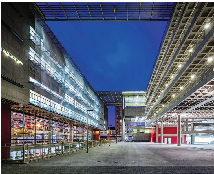
Fig. 45 ETEC Luz, Praça de conexão
