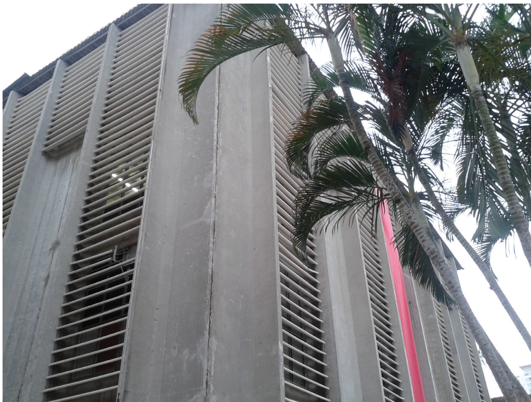
Fig. 39 Edifício da FAUS
