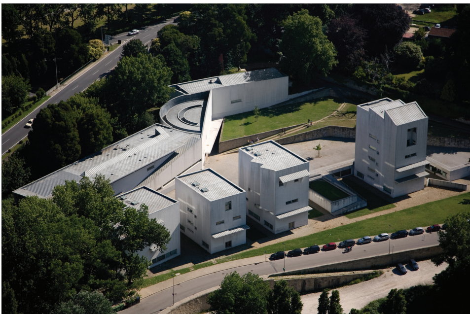
Fig. 96 Faculdade de Arquitetura da Universidade do Porto
