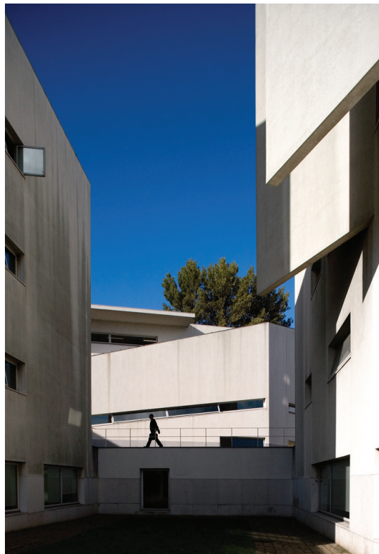
Fig. 104 Faculdade de Arquitetura da Universidade do Porto
