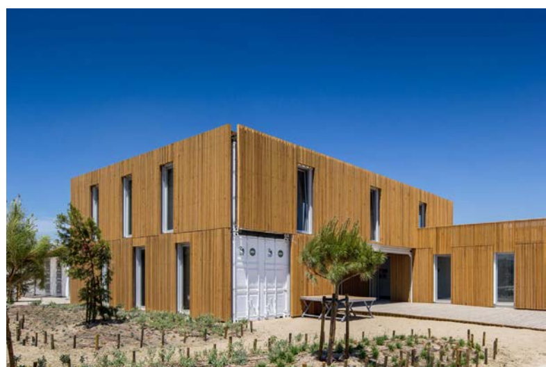
14 | Centro de Interpretação do Ambiente e da Paisagem construído com contentores modulares e revestido a madeira
