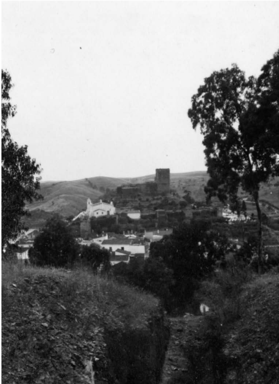
Fig. 25- Vista para o pano norte da muralha, para a mesquita e para o castelo.
