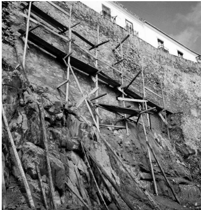
Fig. 47- Fenda vertical no torreão da Porta da Vila, 1951. Fig. 48- Troço de muralha em reparação pela DGEMN, 1976.
