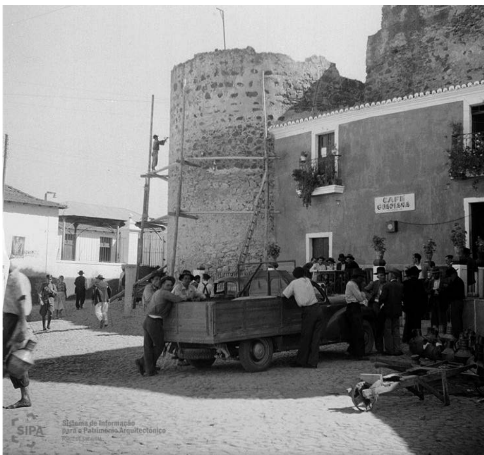
Fig. 55- Planta da zona do Mercado e do torreão semicircular. Fig. 56- Torreão com forma semicircular, segundo fotografias da DGEMN.
