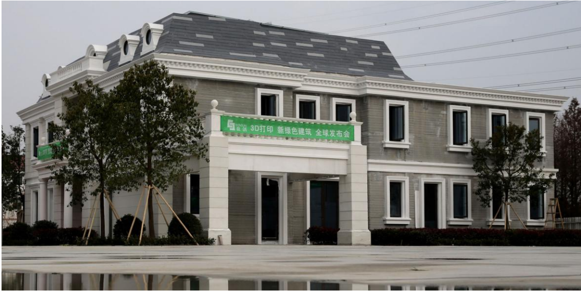
Fig.7: Edifício impresso e montado pela companhia Winsun.
