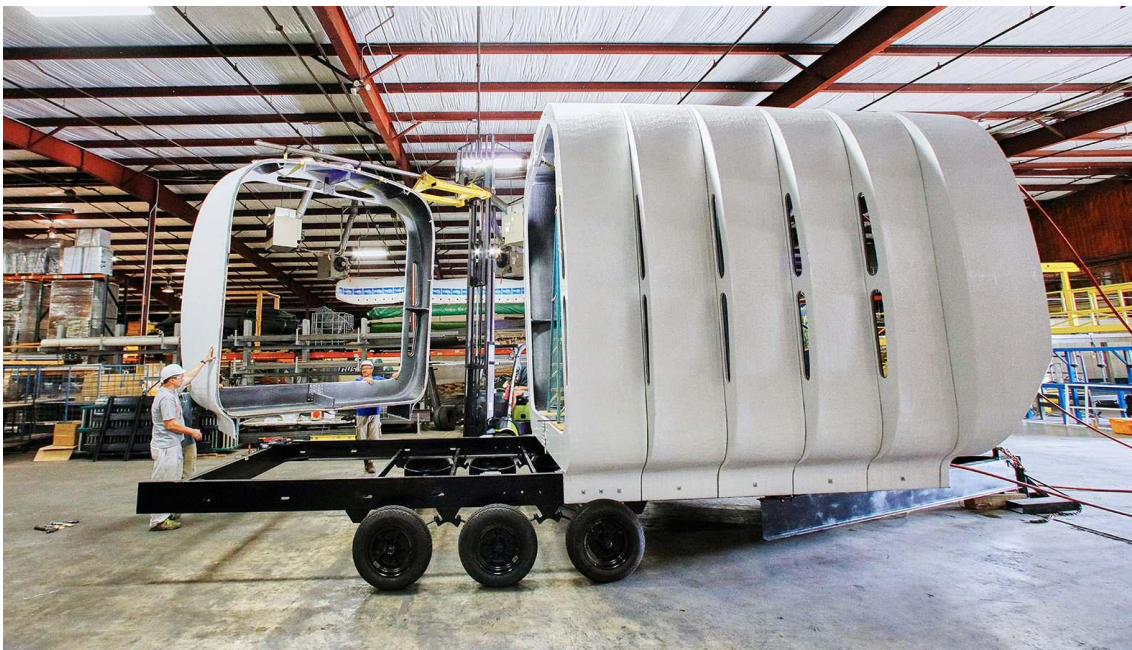
Fig.16: Edifício a ser preparado para o transporte.
