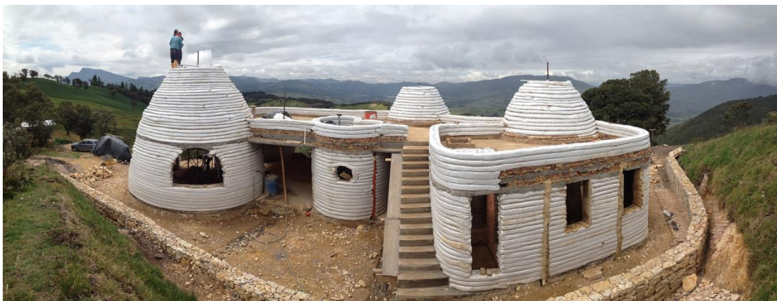
Fig.30: Estrutura montada a base de sacos de areia do Superadobe.
