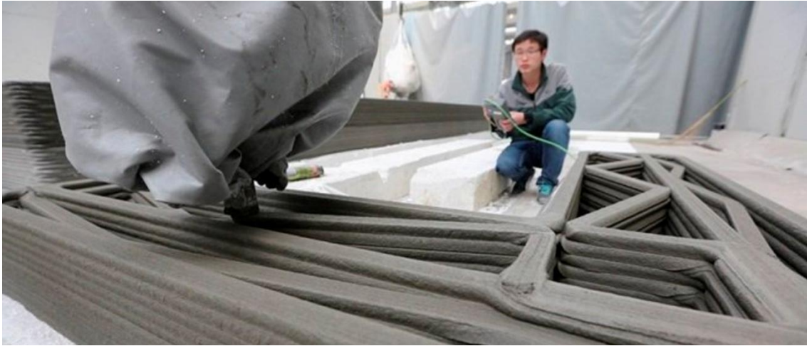
Fig.4: Secção de um edifício a ser impressa no armazém da Winsun.
