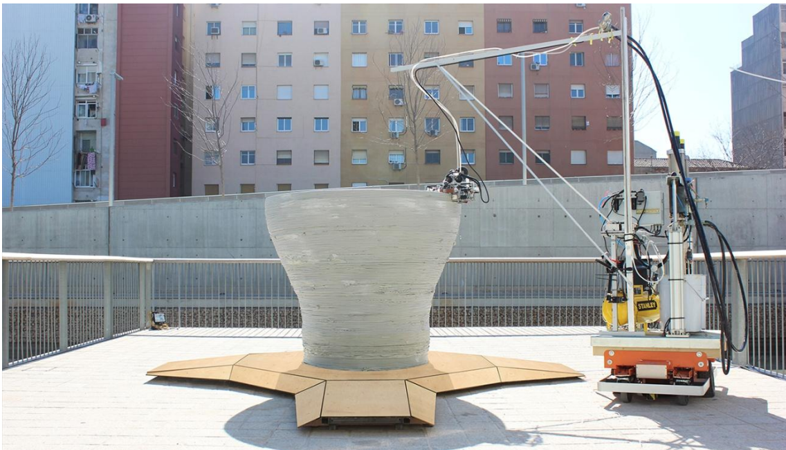
Fig.18: Robô em processo de execução.
