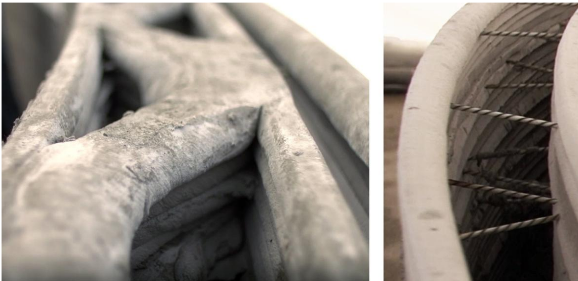
Fig.12: Pormenor da forma da parede e peças estruturais.
