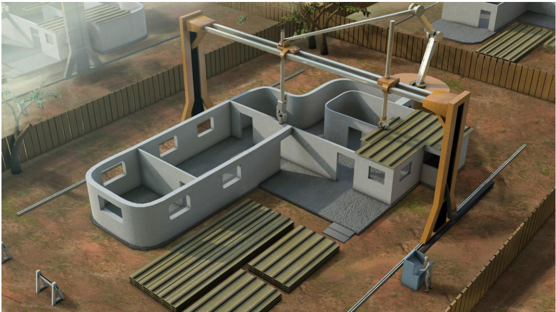
Fig.14: Impressora Contour Crafting no processo de impressão.
