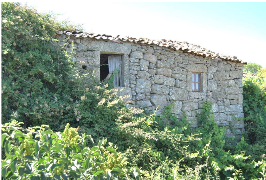
Vista traseira da habitação, fotografia do autor.
