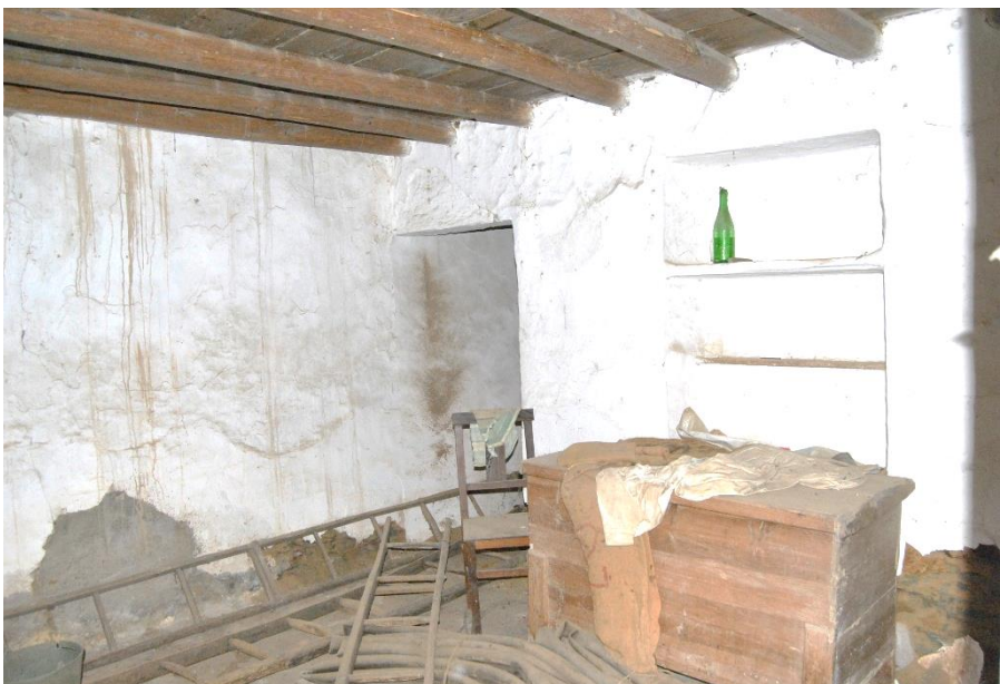
Vista interior do primeiro piso, fotografia do autor.
