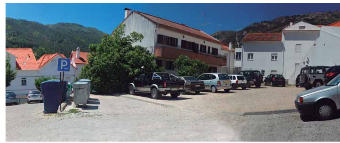
F3 | Fotografia do existente
