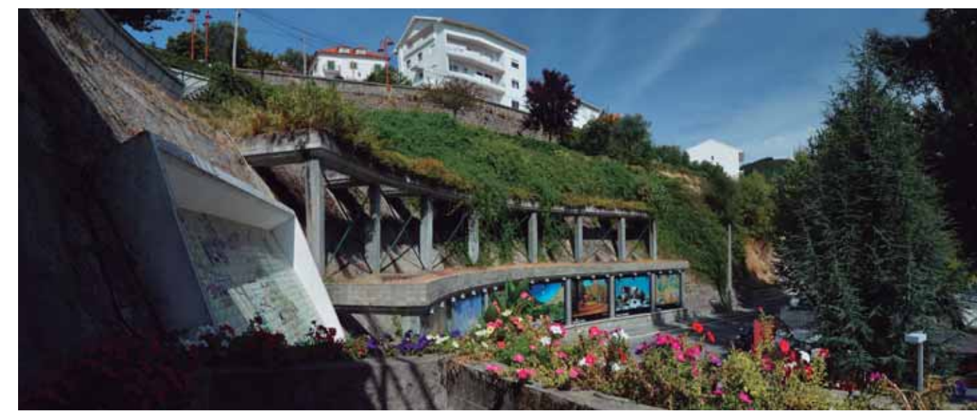
F7 | Fotografia do existente
