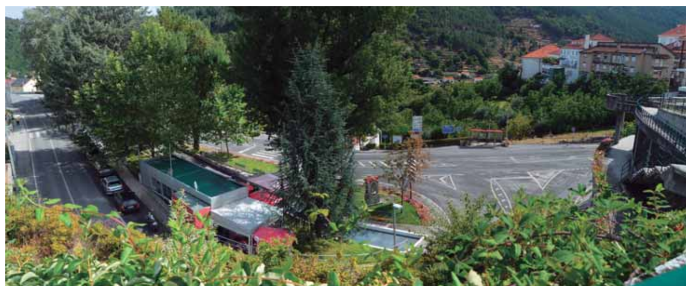
F1 | Fotografia do existente
