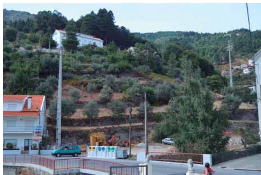
F1 | Fotografia do existente
