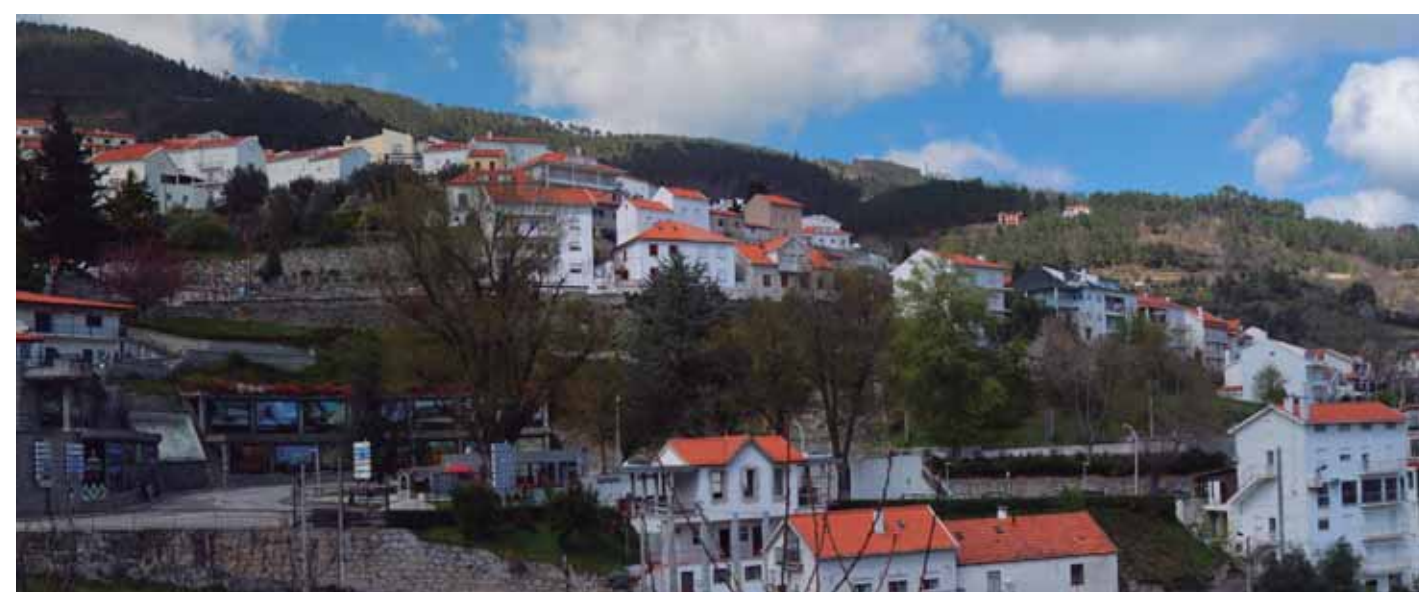
F5 | Fotografia do existente
