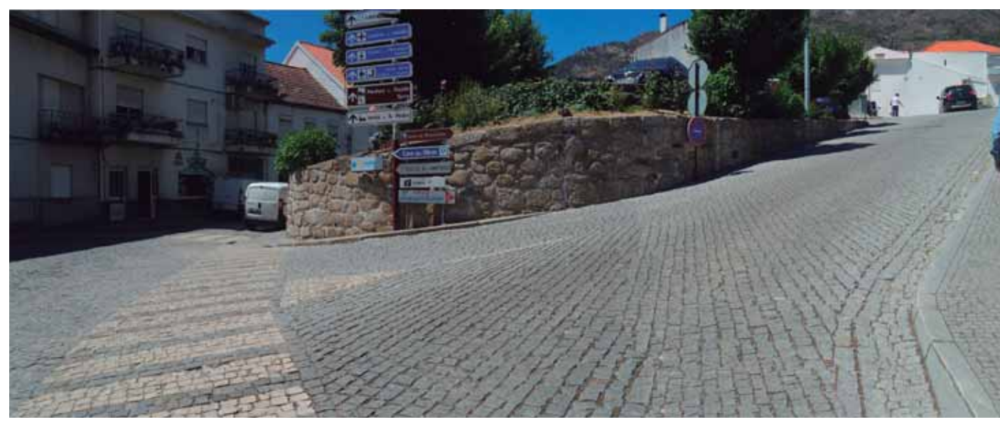
F1 | Fotografia do existente
