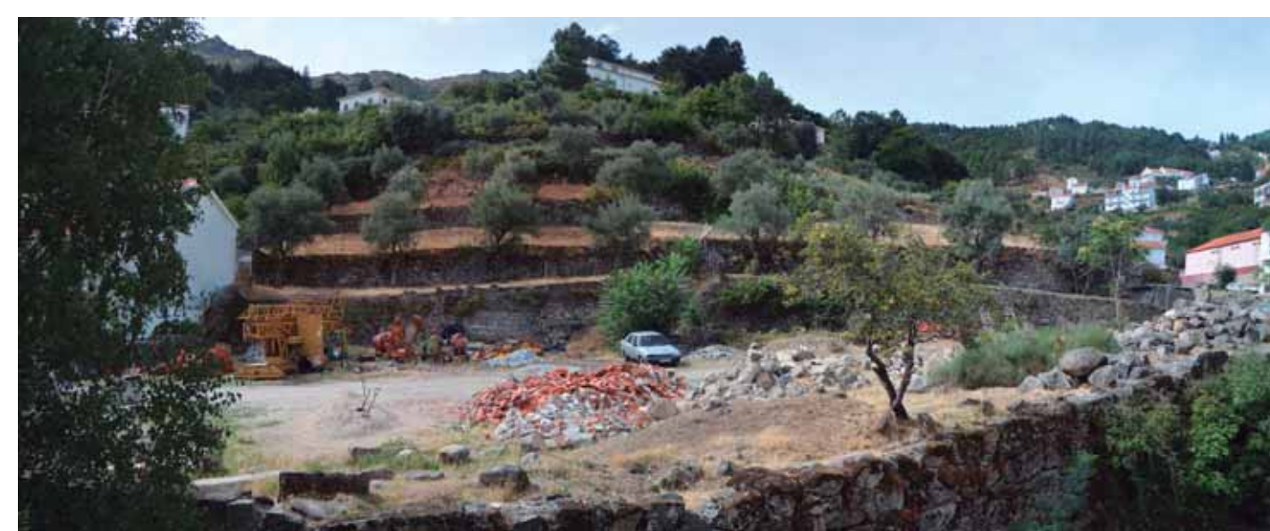
F2 | Fotografia do existente
