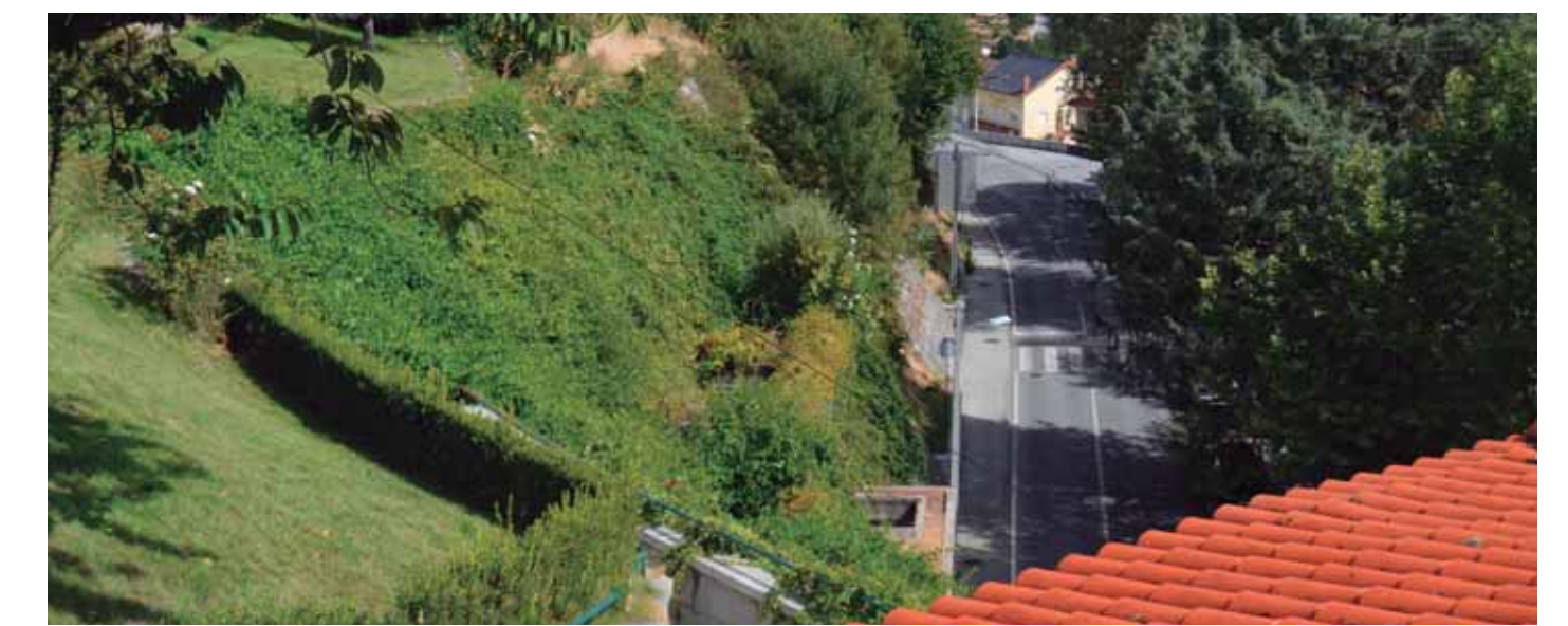
F8 | Fotografia do existente
