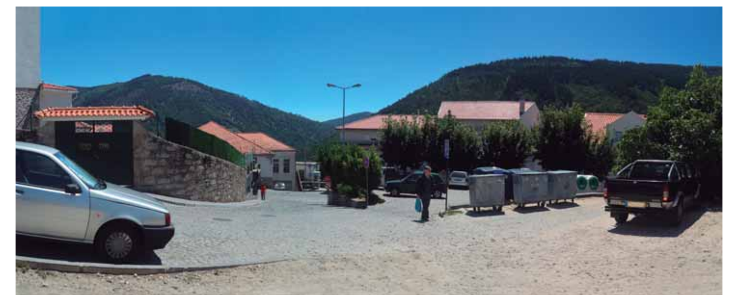
F4 | Fotografia do existente
