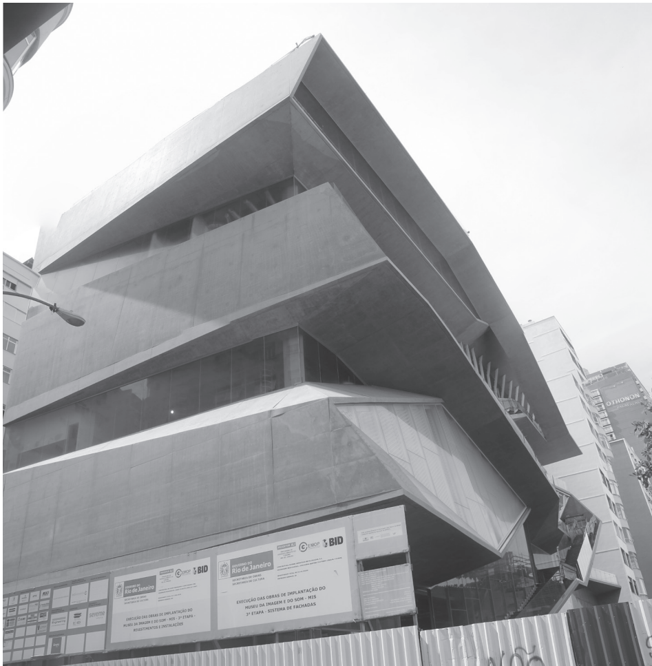
Figura 224 - Esquina da Djalma Ulrich com a Avenida Atlântica Arquivo Pessoal.
