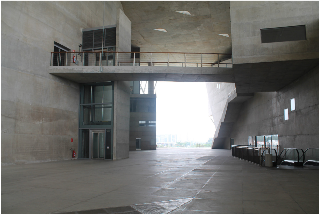
Figura 284: Extremo oeste do edifício (interior)
