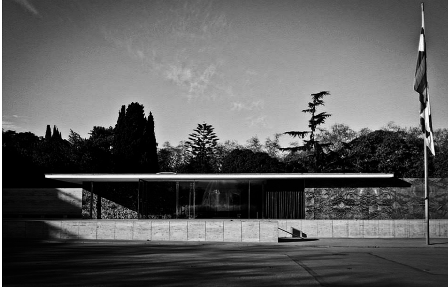
Figura 32 - O Pavilhão da Alemanha na Exposição Internacional em Barcelona, em 1929, projetado por Mies van der Rohe.
