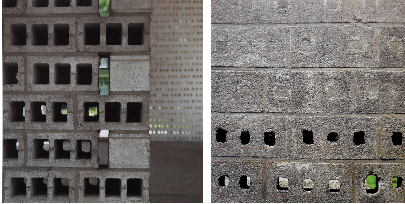
Figura 166 - O tijolo e a grelha de furos do betão.
