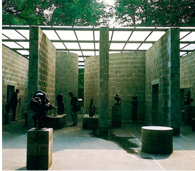
Figura 180 - Os blocos de betão como material escolhido para revestir todos os elementos do pavilhão.
