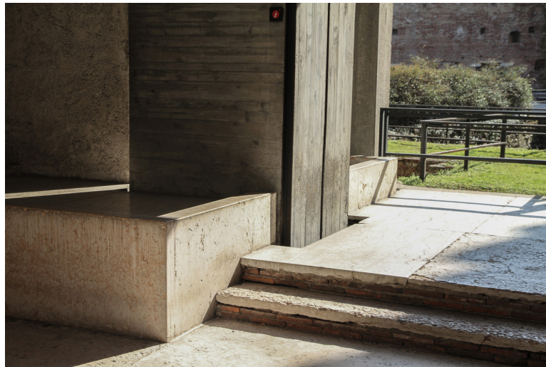
Figura 93 - O contraste da materialidade da construção antiga articulada com a nova intervenção.
