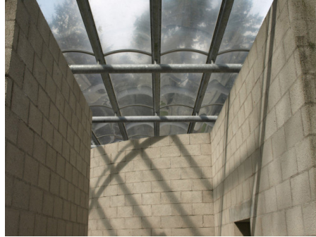
Figura 180 - Os blocos de betão como material escolhido para revestir todos os elementos do pavilhão.
