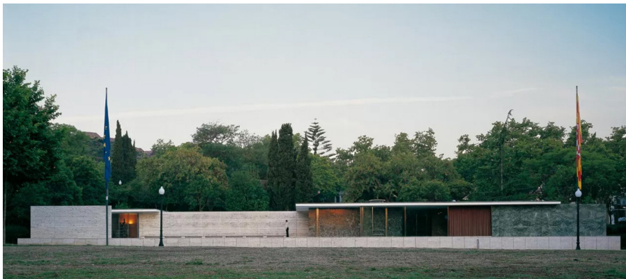
Figura 34 - O pavilhão de Barcelona, reconstruído em 1983 e inaugurado em 1986, no Parque Montjuïc [Fotografia Fundació Mies van der Rohe].
