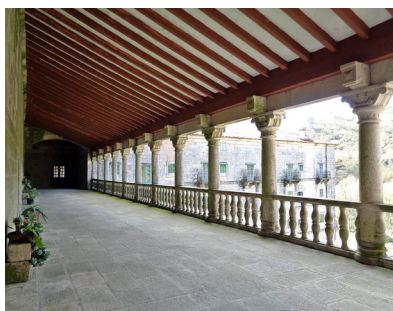
146. Ao fundo da galeria, encontra-se a porta de acesso à cozinha onde agora comem os monges
