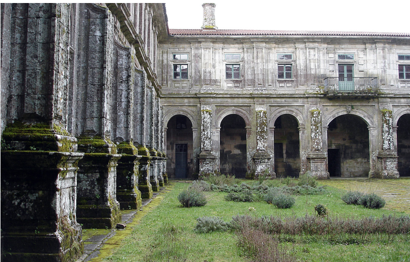
48. O ritmo dos pilares fortes e austeros do Claustro de los Caballeros
