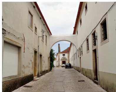
158. A entrada do convento localiza-se na Rua da Misericórdia. É possível ver uma das arcadas do aqueduto do séc. XVIII que transporta água até à cerca
