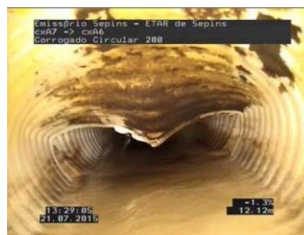
Figura 2.9 – Coletor deformado (foto cedida por INOVA, s/d).
