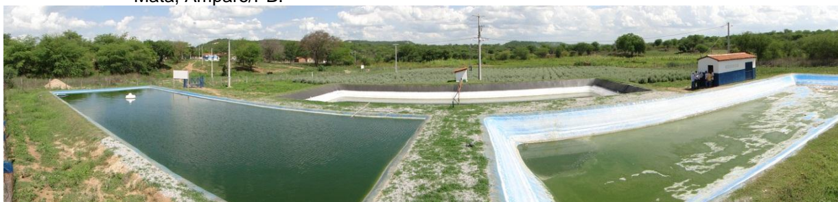
Figura 12 – Reservatório de contenção do concentrado e tanques destinados à criação de tilápia. Ao fundo, plantio da erva-sal, na Fazenda Mata, Amparo/PB.
