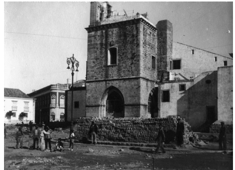
Fig. 3 – Fotografia do Largo da Sé de Faro, após o desaterro de finais do século XIX.
