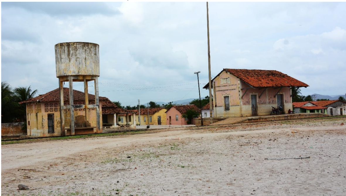
FIGURA 126 – Estação Ferroviária de Cana Brava – Buriti dos Montes.
