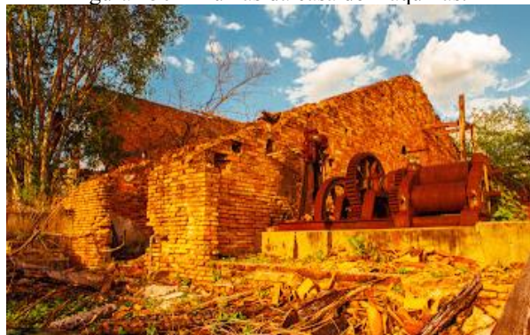
Figura 150 – Ruínas da casa de máquinas.
