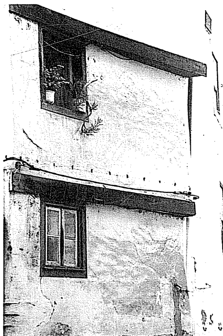
Coimbra, Rua de Sargento-Mor. Pormenor do travejamento em madeira nos ressaltos da fachada.
