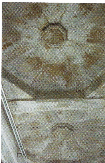
FOTO 13 – Cobertura da chamada manga norte
