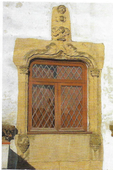
FOTO 12 – Janela na fachada ocidental
