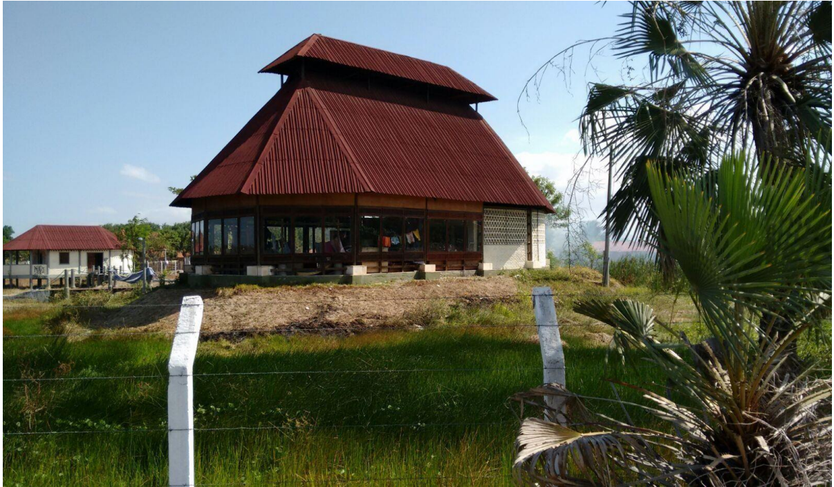
Figura V.5.4.34: Local do Memorial Cacique Perna de Pau / Centro de Produção Cultural Tapeba Fonte: Foto tirada do celular da autora (2015) para registrar o abandono desse equipamento turístico.
