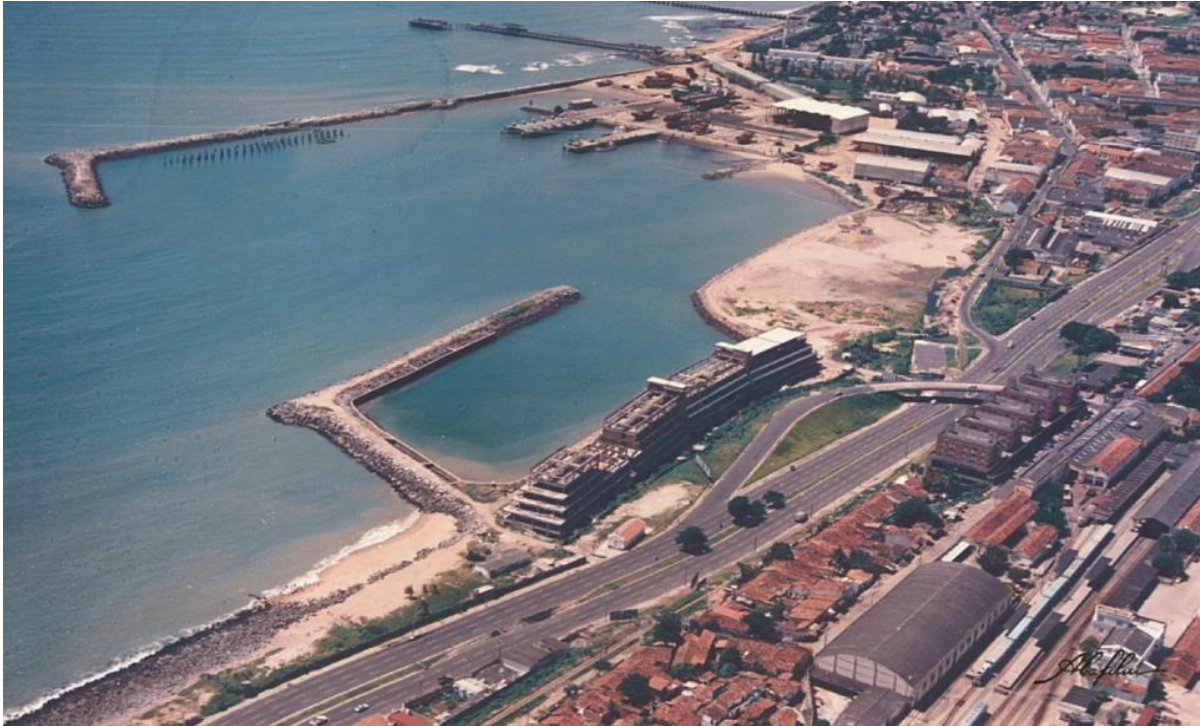
Figura IV.4.2.17: Série de espiões construídos para diminuir os efeitos erosivos decorrentes da construção do Porto de Mucuripe em Fortaleza. O antigo Porto de Fortaleza foi aproveitado para a construção de marinas associado a um empreendimento hoteleiro de grande porte
