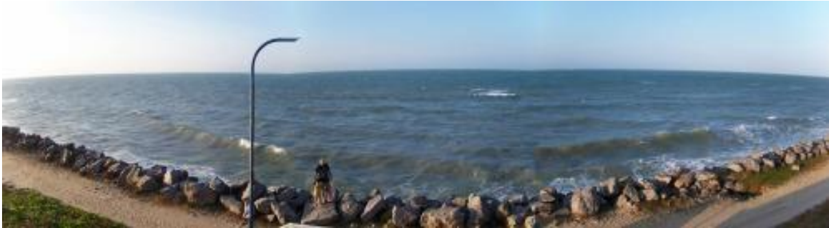
Figura IV.4.2.20: Destacando a construção de muro de proteção Fonte: Sesc – minhas andanças:... (2012).
