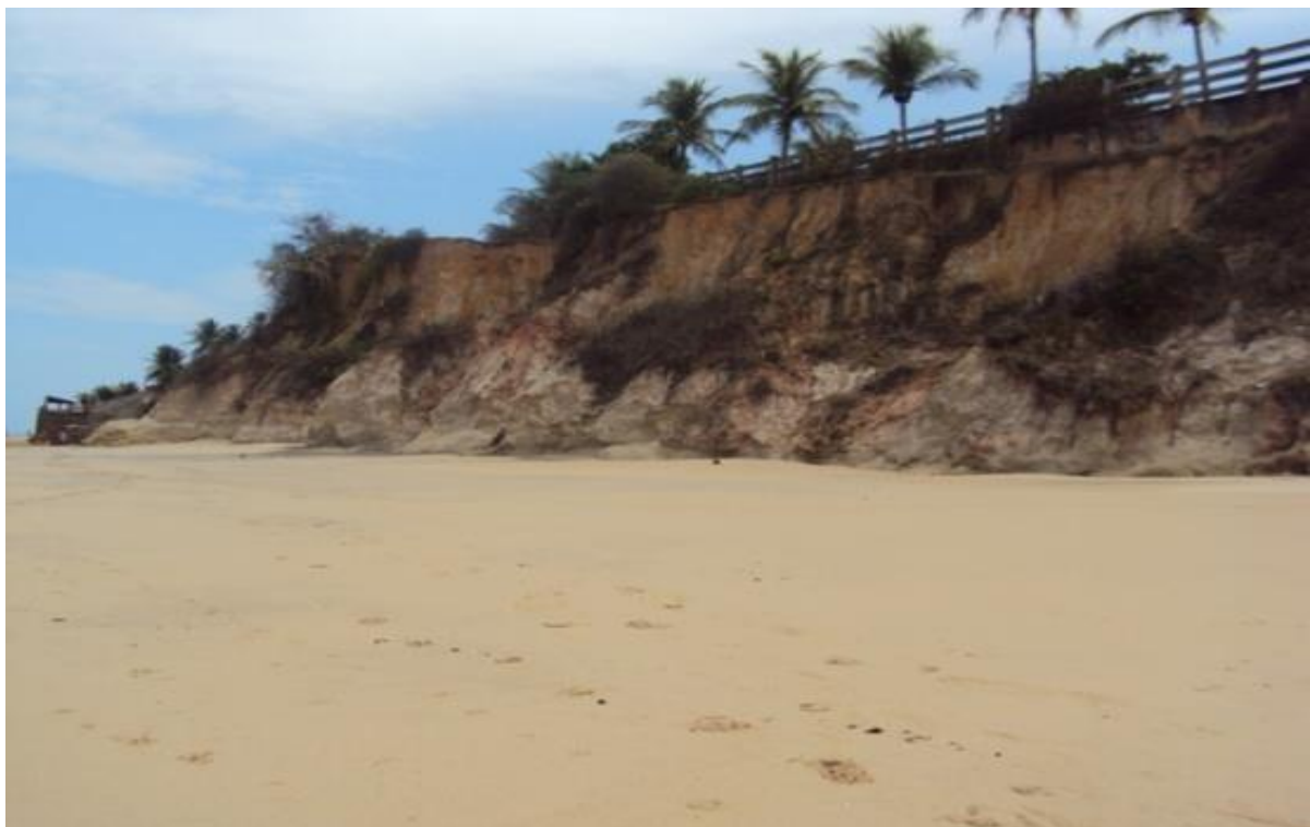
Figura IV.4.2.22: Construções irregulares e o processo de erosão das falésias nas praias do Pacheco e Iparana – Ceará – Brasil. Fonte: Acervo fotográfico do SESC Ceará (2010).
